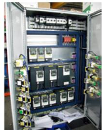
La concentration des variateurs de vitesse variable peut faire monter la température intérieure jusqu'à 70 °C voire davantage (si aucune solution thermique n'est installée).
